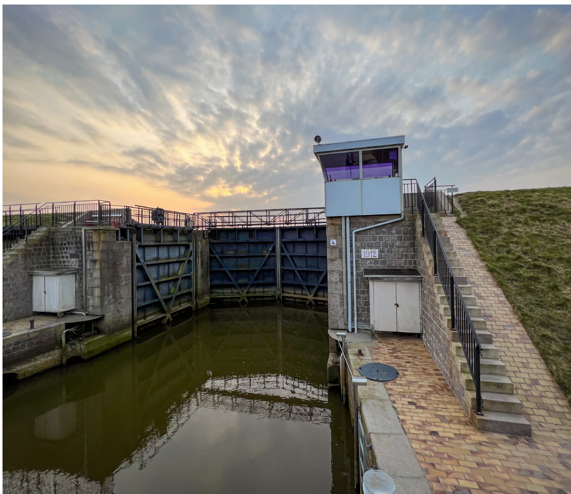
Kammerslusen bestemmer afstrømning fra Vesteråen - den sidste strækning af Ribe å inden udløb i havet. Når slusen er lukket, er der ingen afstrømning til Vadehavet
